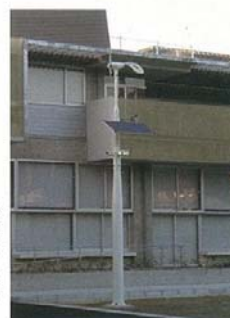
岐阜県岐阜市立岐阜小学校（定格出力 風力 1,000W+太陽光 60W）
