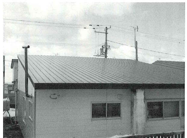
屋根をリフォームした住宅
