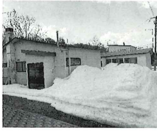
解体予定の栄町旧教職員住宅
