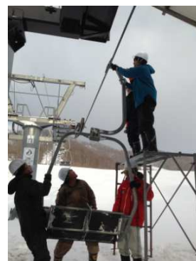
リフト取付状況
