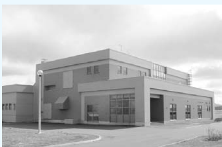
羽幌浄化センター(羽幌町字朝日)
