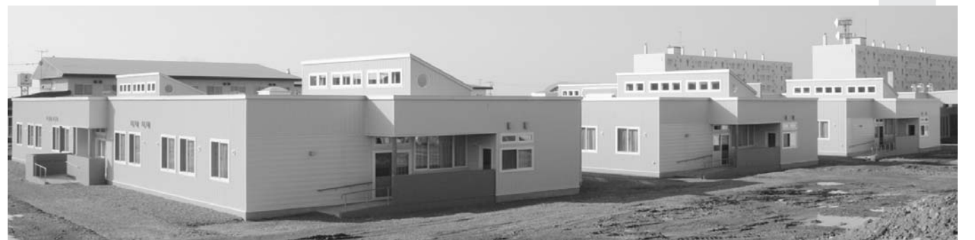
東側から見たユニット棟の外観。ユニット棟が3棟並びます(ひとつの棟に2つのユニットが配置されています)。右奥に玄関、事務室や医務室、厨房などの管理サービス棟があり、来年度工事の多床棟と渡り廊下でつながります。
