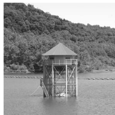
田畑に水を供給し、羽幌町の農業を支えている二股ダムの取水塔
