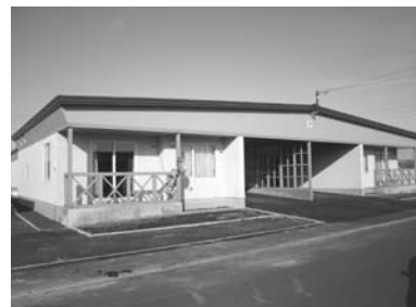
平成13年から計画的に整備が進められている、朝日地区の公営住宅建設事業
