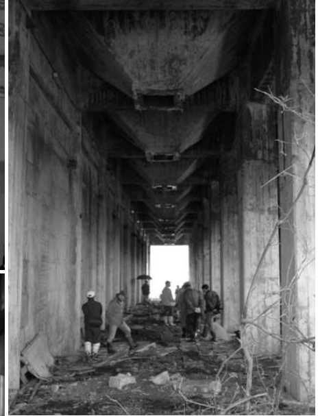
ホッパー(貯炭場)の内部。ここを鉄道が通り、天井部に見える搬入口から石炭が運び込まれていました。実は公民館の横に常設されている機関車は、ここで使われていたものなのです。
