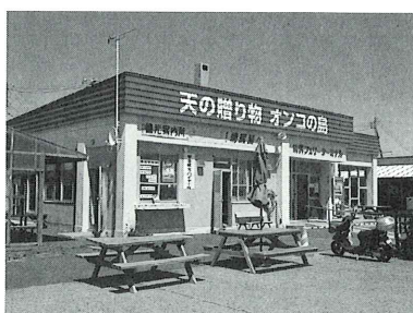
焼尻フェリーターミナル
